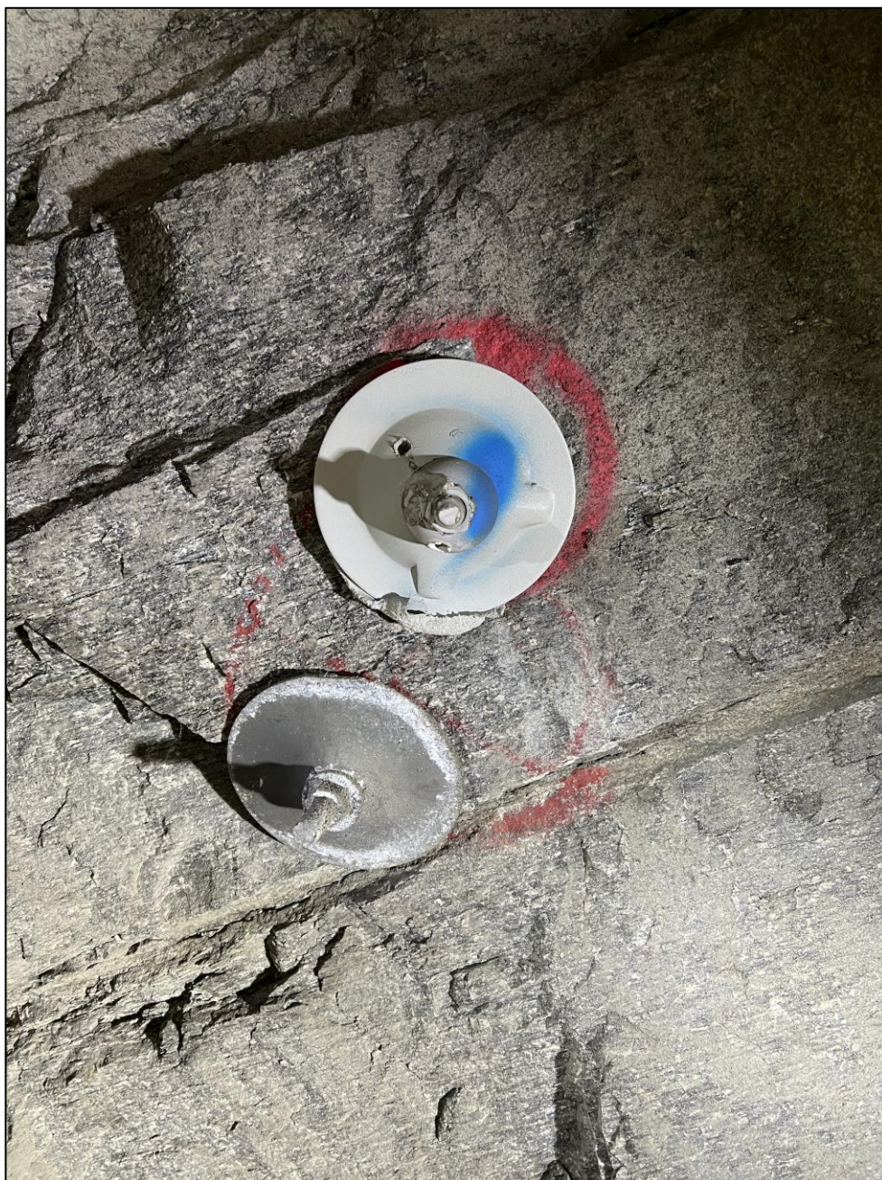
Foto 7. Eksempel på erstattet bolt.
