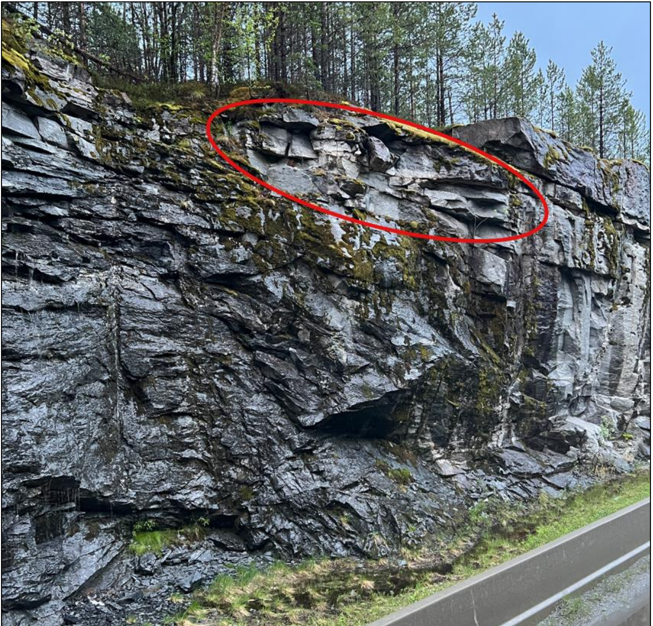
Foto 3. Oversikt over parti med løse blokker ved forskjæring sør. Det anbefales å renske løst berg kontrollert ned. Boltesikring vurderes etter rensk.
