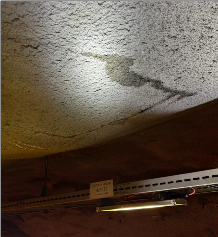
Foto 5. Pel 172 h. side. Fukt og riss i brannsikret PE-skum.
