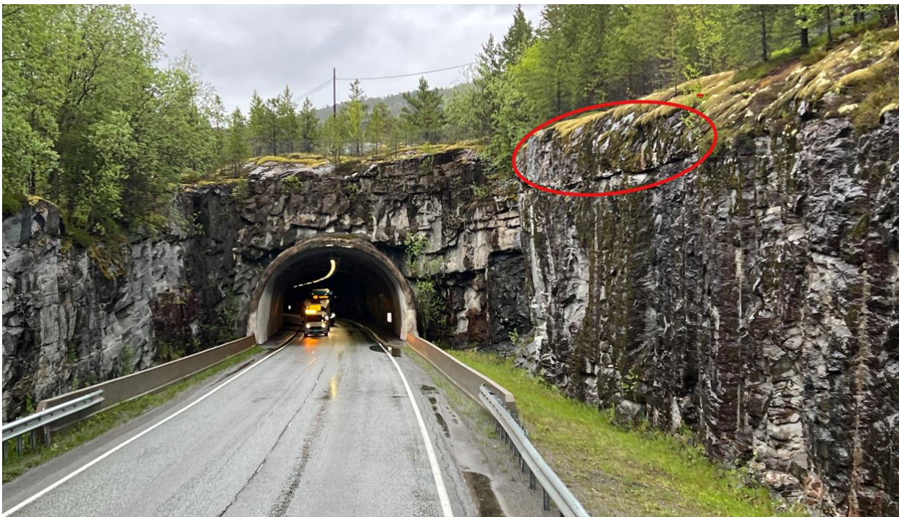
Foto 2. Oversikt forskjæring sør. Området markert med rødt anbefales å boltesikres. Bolteplassering, antall og dimensjon på boltene må detaljprosjekteres av geolog etter rensk.
