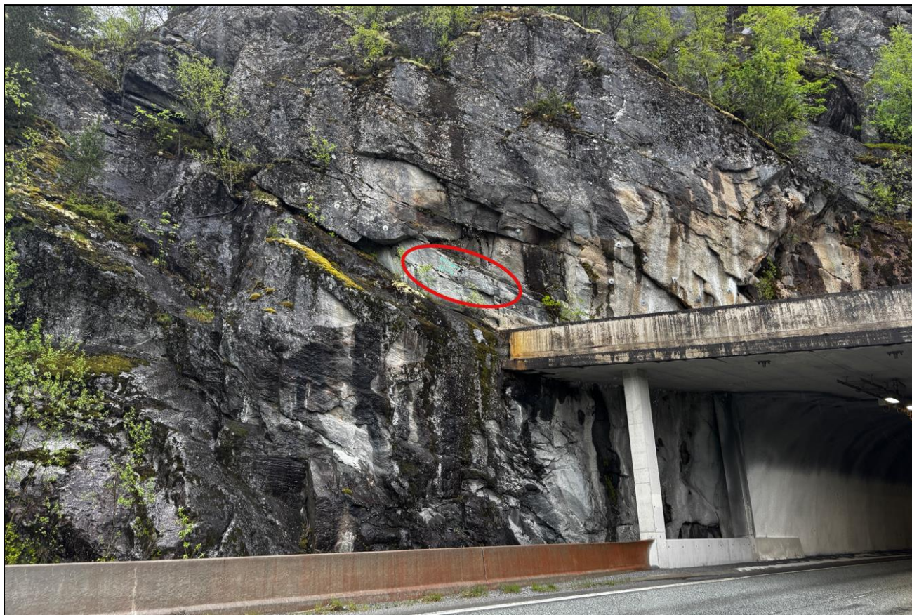
Foto 1. Oversikt forskjæring nord. Rød sirkel indikerer blokk som tidligere er merket med rensk/bolt. Det anbefales å renske blokken ned. Boltesikring vurderes etter rensk.
