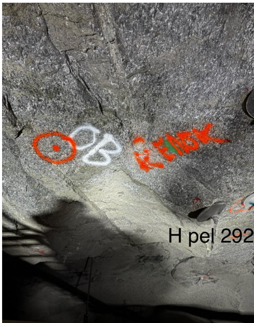
Foto 9. Pel 292, h.side. Eksempel på område med avløst berg og bom.
